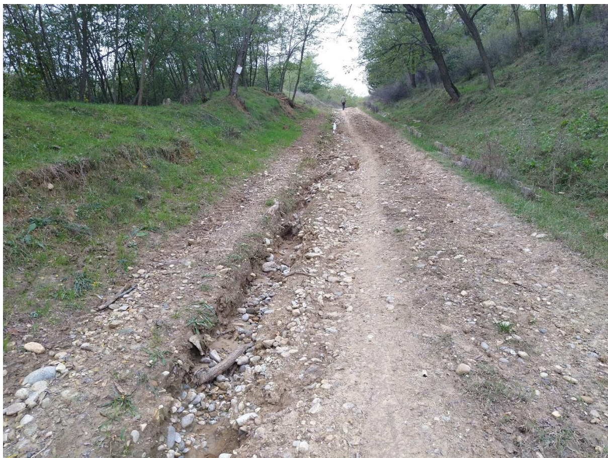
Traseul conductei pe drumul din DJ 661 catre rezervorul de apa al comunei Bărbătești Local conducta este scoasa la suprafata de eroziunea provocata de apele pluviale
